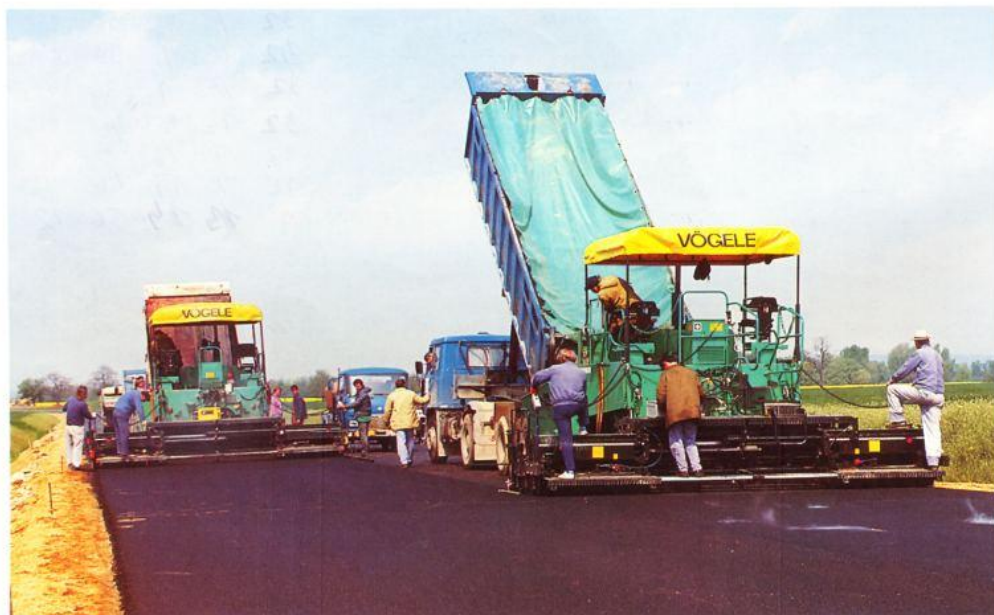
Pokládka obalových směsí na R52 Brno-Mikulov
