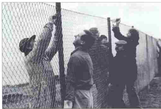
Brigádníci při opravě oplocení autodromu
