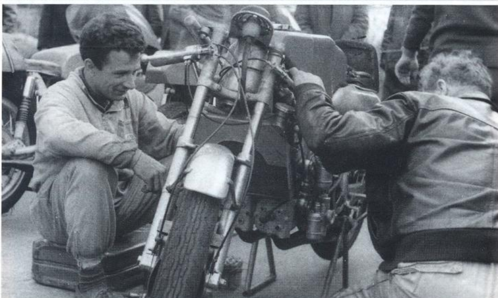
Ostrava 1968 - Mechanik Jarda Šeda ladí čtyřválcovou Jawu.
