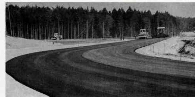
Dokonalá konstrukce vozovky závodní dráhy je dílem n. p. Silnice Brno — závod Znojmo a n. p. Dopravní stavby Olomouc — závod Brno.
